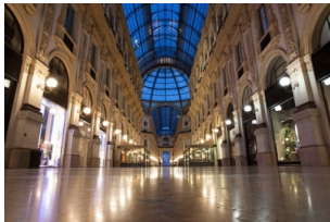
埃马努埃莱二世拱廊桥
